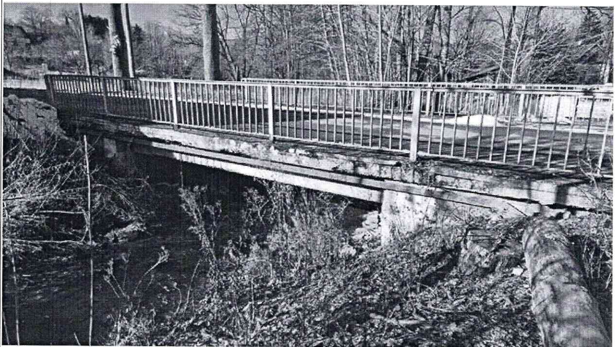
Ansicht Zufahrt aus Richtung Bösenbrunn
