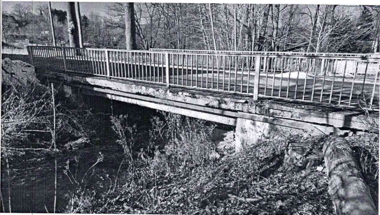
Ansicht Zufahrt aus Richtung Bösenbrunn
