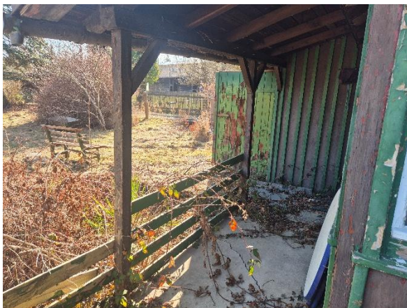
überdachter Terrassenbereich Gartenhaus
