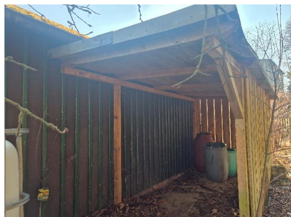
Anbau Unterstand Gartenhaus
