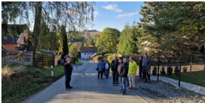
Foto: Stadtverwaltung Oelsnitz/Vogtl. (Jens Persing erklärt die notwendigen Maßnahmen zur Entwässerung an der Alten Schönecker Straße in Raasdorf)
